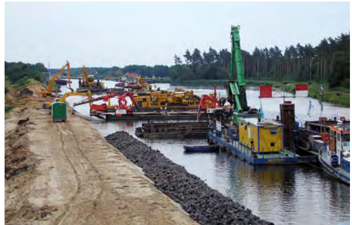
Kanalverbreiterung – Herstellung eines neuen Deckwerkes mit Tondichtung
