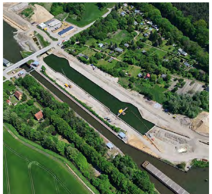
Ersatzneubau Schleuse Zerben
