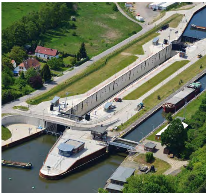
Ersatzneubau Schleuse Wusterwitz
